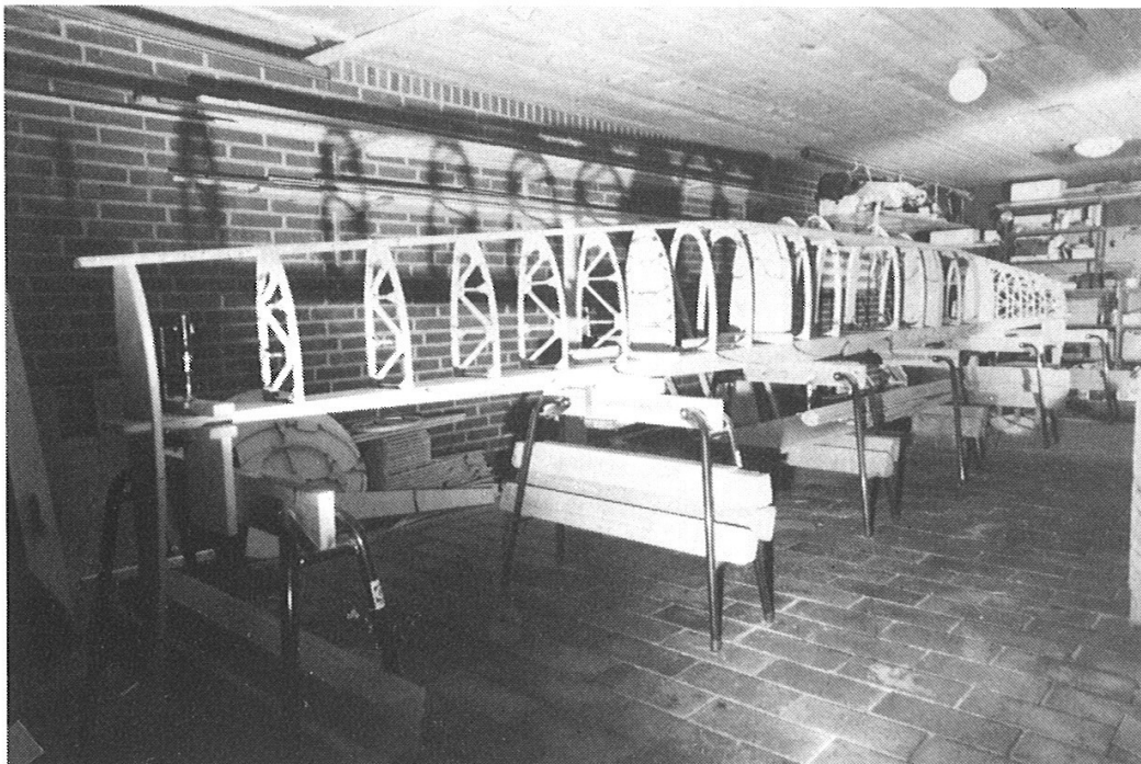
Vingen oplagt på plan med næseribber monteret. Foto: Hardy Vad
